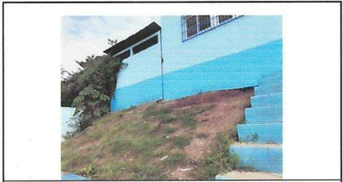
Foto 6: Vista del graderío en mal estado que necesita reparación.
