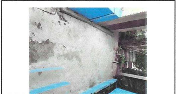
Foto 2: vista de la torta de cemento del frente de la cocina que necesita reparación.
