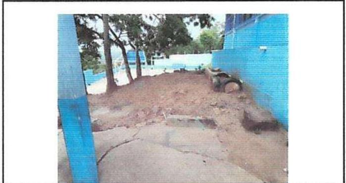
Foto 4: sustitución de torta en mal estado.
